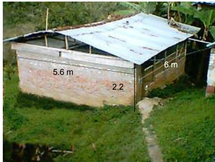
Figura 2. Fotografía externa del galpón
