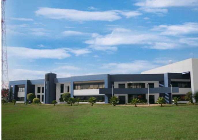
Imagen 11. Edificio de Servicios
