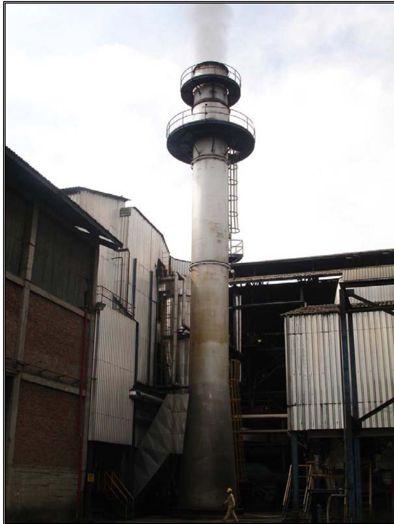
Figura 9. Chimenea caldera 5 ingenio la cabaña s.a.
