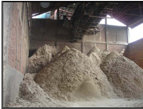
Figura. 2. BAGACERA. Almacenamiento de combustibles Bagazo y Polvillo para alimentación a las calderas.
