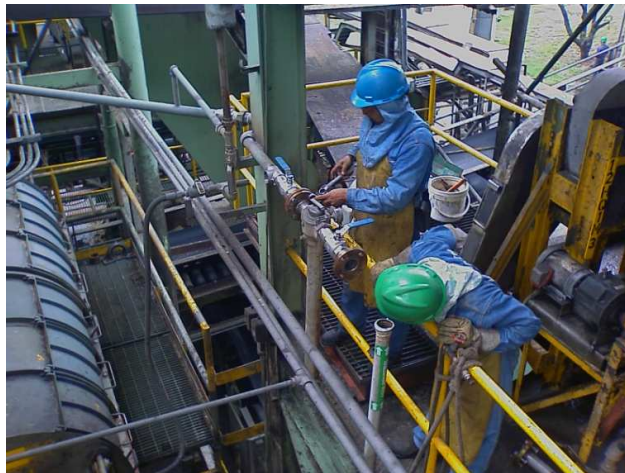
Figura 8. Instalación de filtros en la línea de agua
