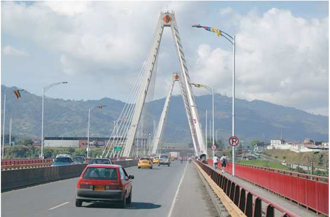
Figura 1. Viaducto entre Pereira y Dosquebradas
