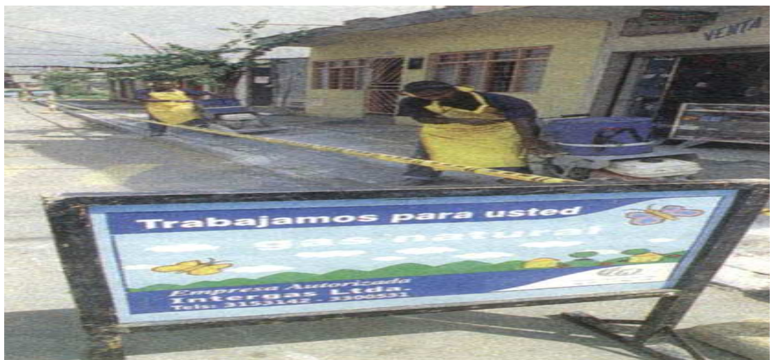
Figura 5. Obras de Infraestructura
