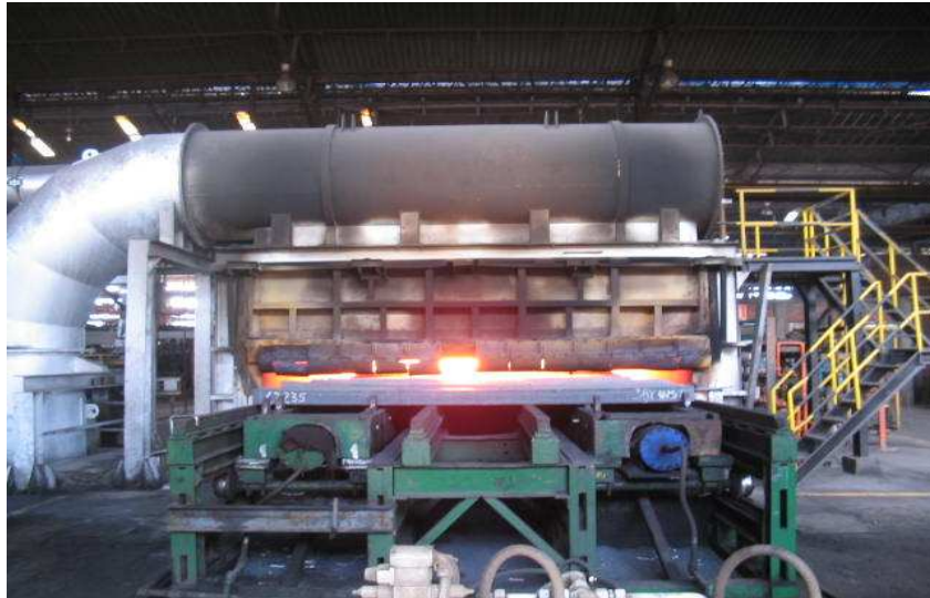
Figura 6. Horno Bendotti del Área de Laminación
